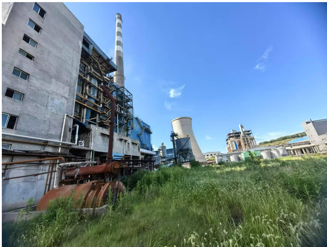
图 2-2 新建锅炉布置区域现状
